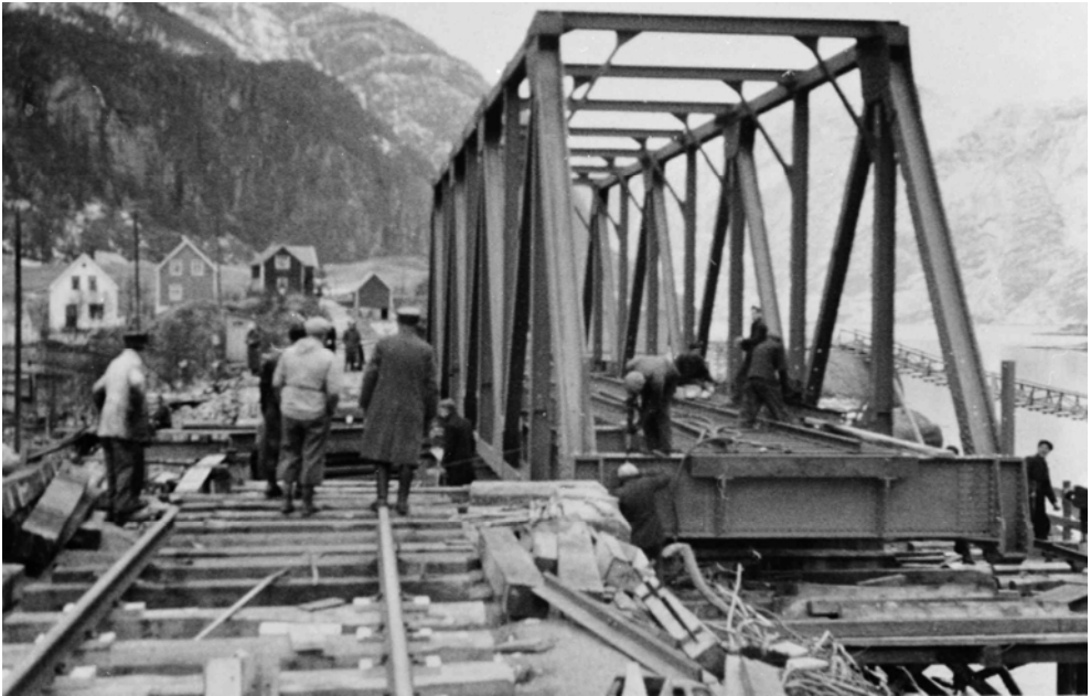
Montering av ny fagverksbru ved Stanghelle.
